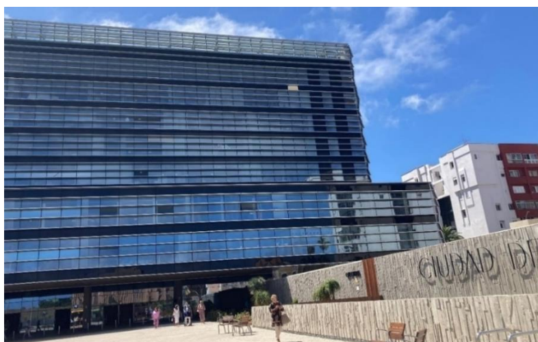
Imaxe: Vista do edificio da Cidade da Xustiza de Las Palmas. Febreiro 2024.
