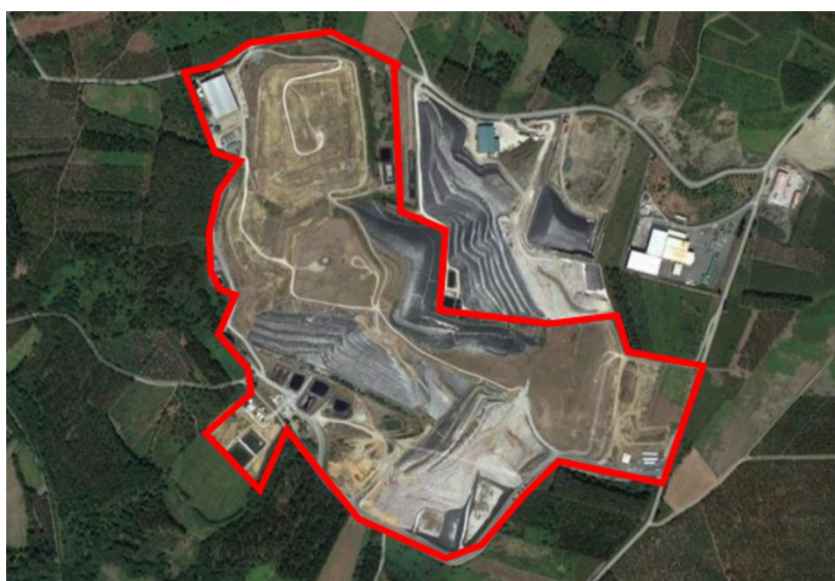
Figura 24. Vista aérea do vertedoiro de Areosa
