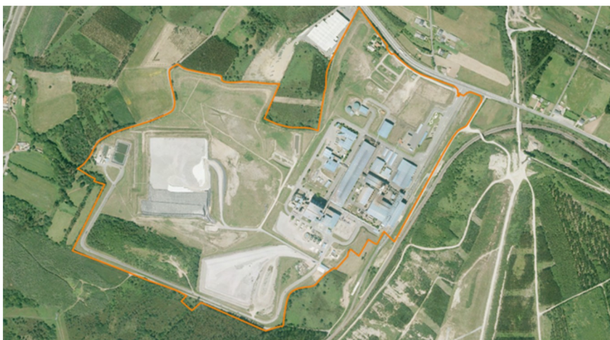
Figura 23. Vista aérea das instalacións que conforman SOGAMA
