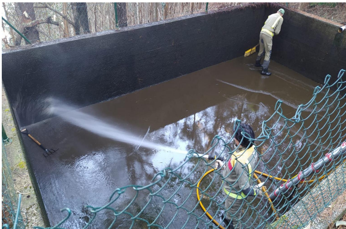
Brigadas do distrito forestal I realizando traballos de mantemento de puntos de auga
