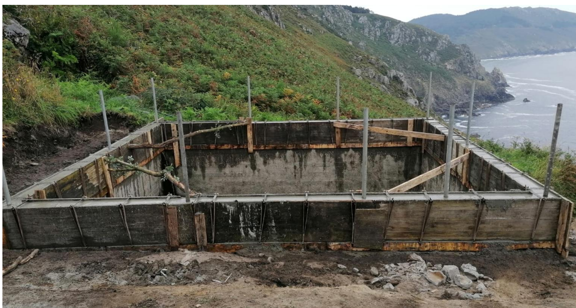
Construción de depósito de auga no distrito V
