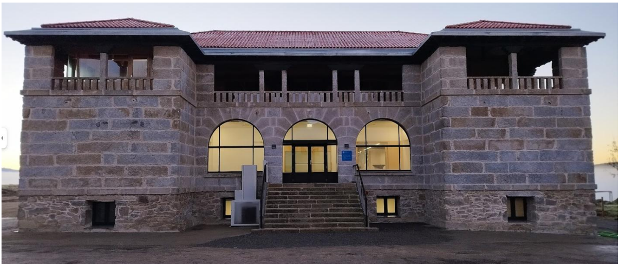
Edificio rehabilitado da antiga lavandería no CILL de Toén
