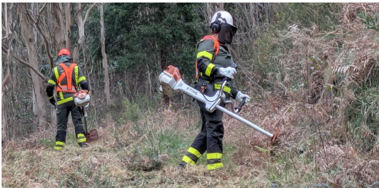
Desbroce manual en el distrito forestal V
