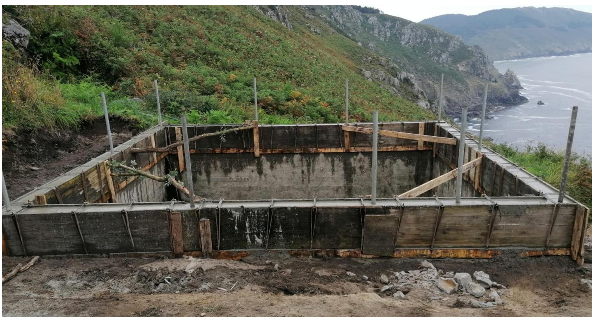
Construcción de depósito de agua en el distrito V
