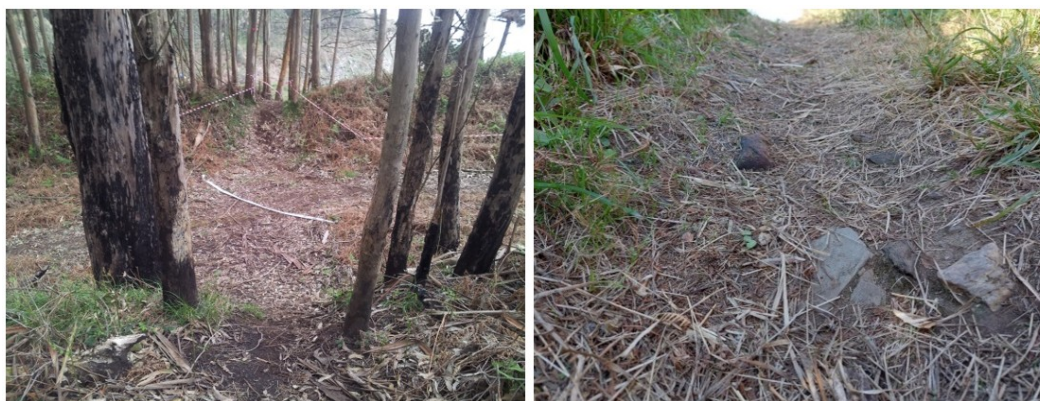
Imaxe 13. Á esquerda, sinalización do trazado dunha proba deportiva atravesando dous muros e o foso do castro de punta Roza. Á dereita apréciase o material lítico da muralla aflorando pola erosión provocada polo tránsito intenso sobre a estrutura.
