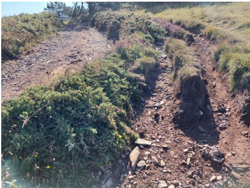
Imaxe 11. Exemplo de erosión en tramo en pendente provocado polo tránsito intenso de bicicletas, favorecendo a apertura de bandas adxacentes, degradación do hábitat, ampliación da anchura do camiño e erosión do firme.
