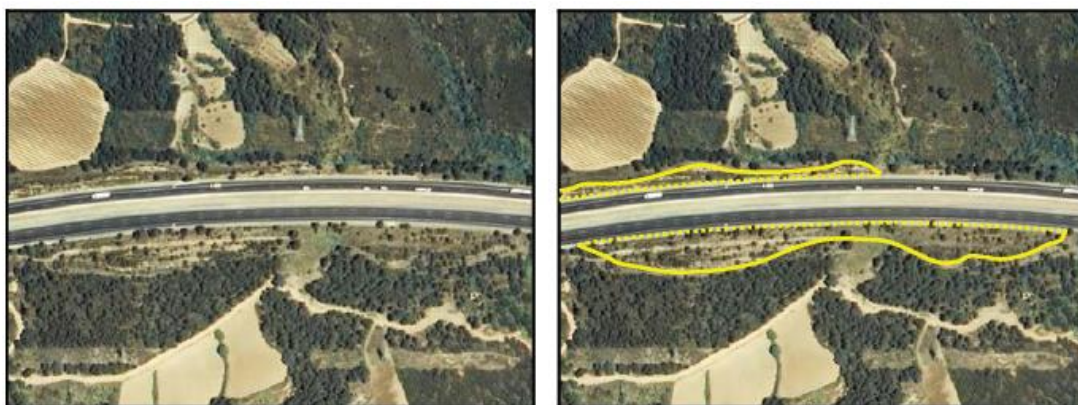
Talud – TIPO_0006: “desmonte”
