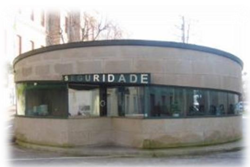
Edificio de seguridade no Parlamento de Galicia
