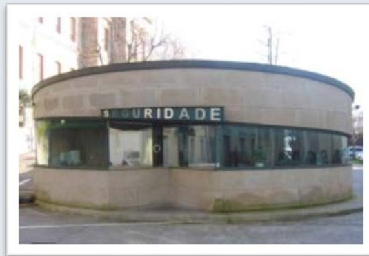
Edificio de seguridade no Parlamento de Galicia
