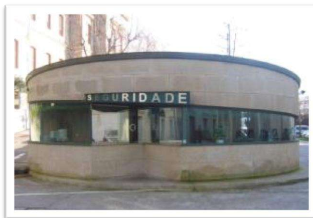
Edificio de seguridade no Parlamento de Galicia
