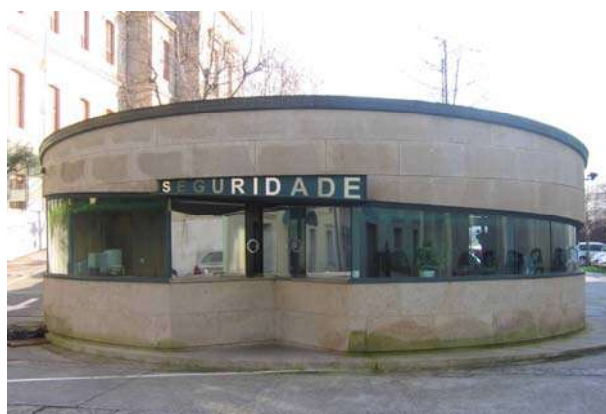
Edificio de seguridade no Parlamento de Galicia
