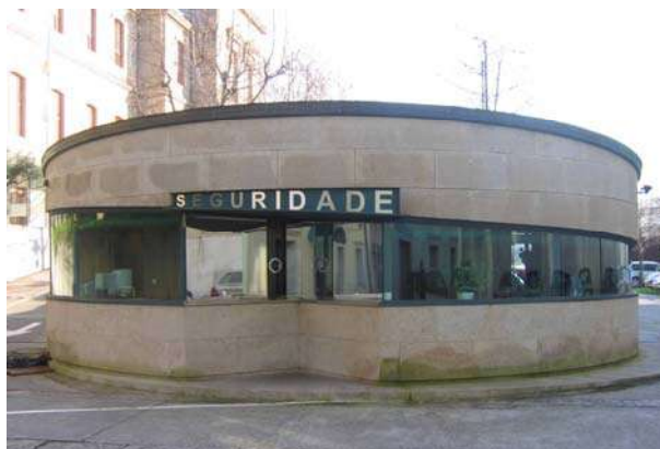
Edificio de seguridade no Parlamento de Galicia
