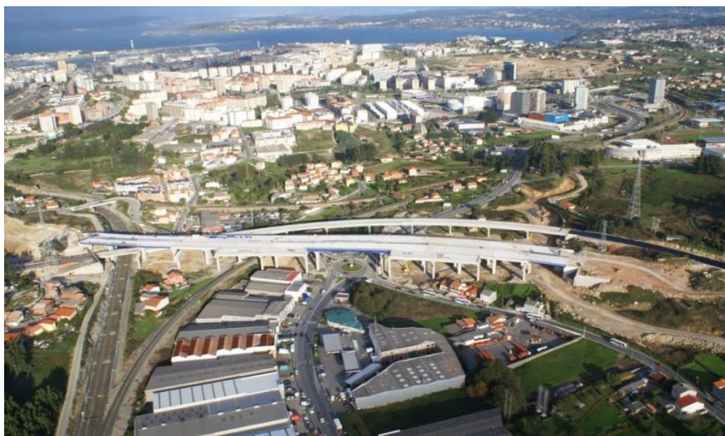
Terceira Rolda da Coruña durante a súa execución
