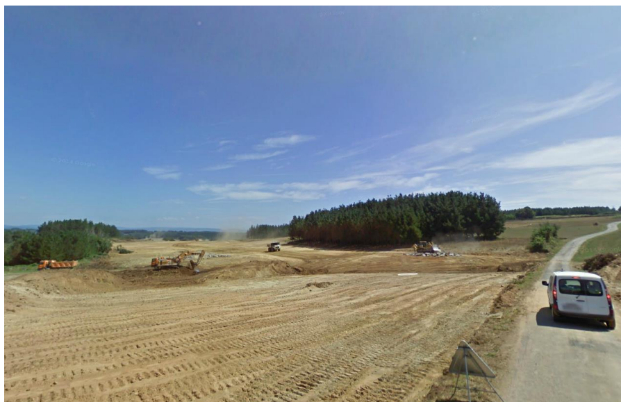
Obras na A-54 (Santiago – Lugo)
