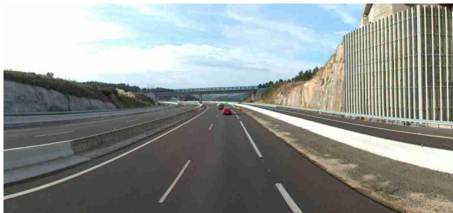
Autoestrada AG-55 A Coruña - Baio
