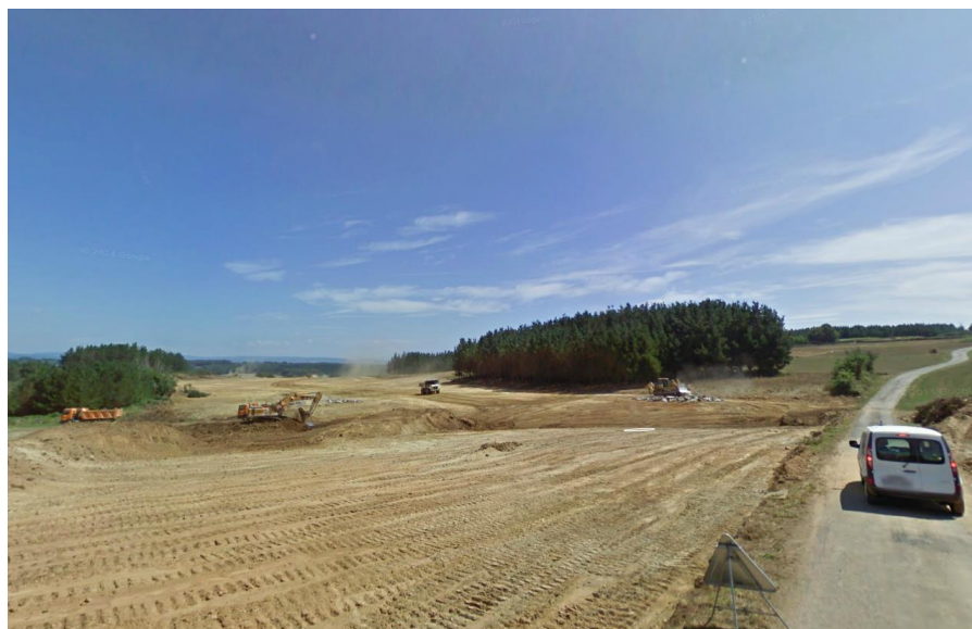
Obras en la A-54 (Santiago – Lugo)
