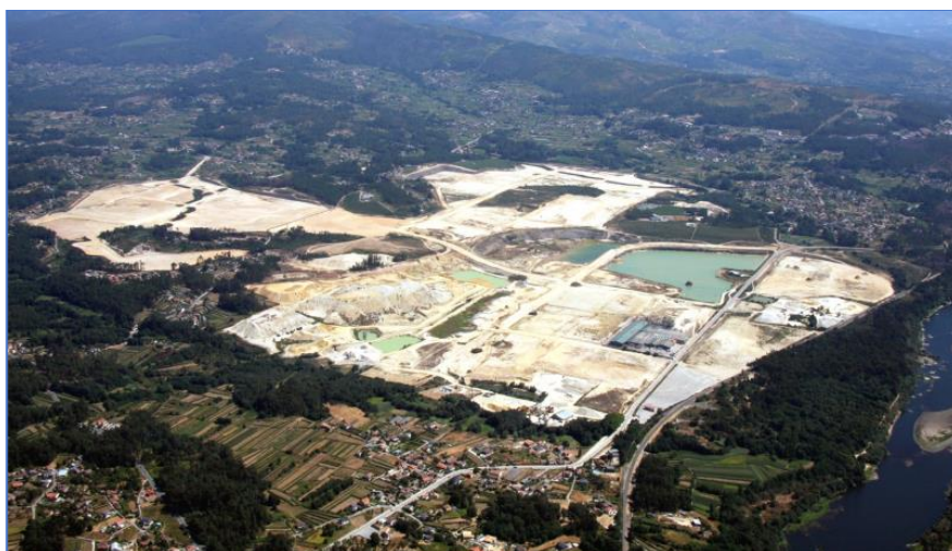
La PLISAN cuenta con una superficie total de casi 3.100.000 m 2
