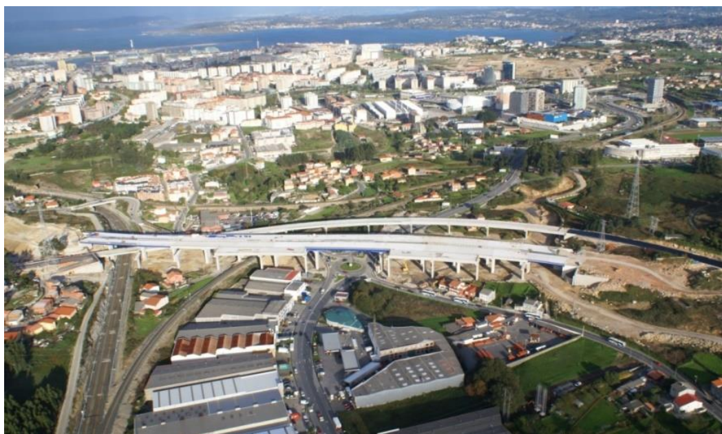
Tercera Ronda de A Coruña durante su ejecución
