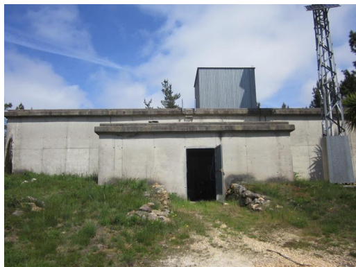
Panel solar no depósito de begonte
