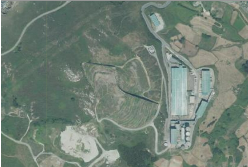
Figura 22. Vista aérea de las instalaciones de Nostián
