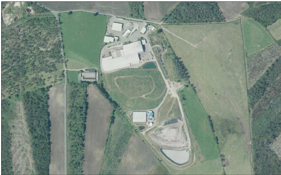
Figura 23. Vista aérea de las instalaciones del Complejo Medioambiental de la Mancomunidad de A Serra do Barbanza
