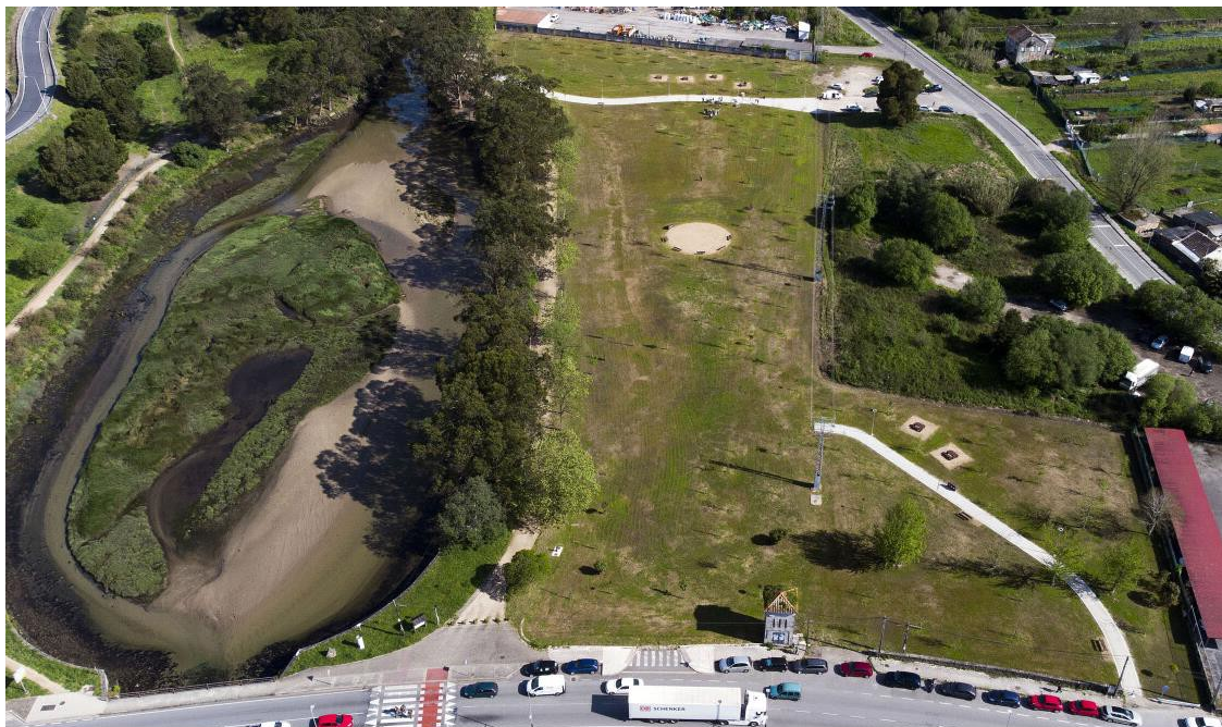
Imaxe 5: Estado final das 2 parcelas tralas obras de demolición e restauración
