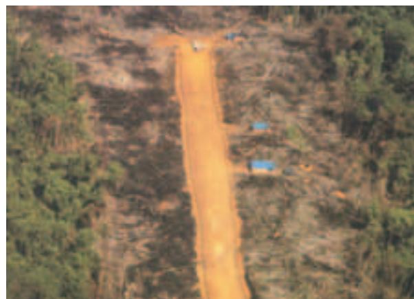
CORTA DE ÁRBORES PARA A CONSTRUCCIÓN DE ESTRADAS
