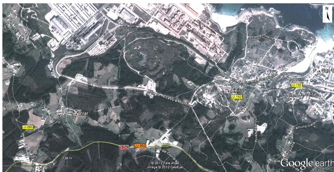
Imagen 03.- Vista aérea Complejo Industrial San Ciprián. Accesos.
