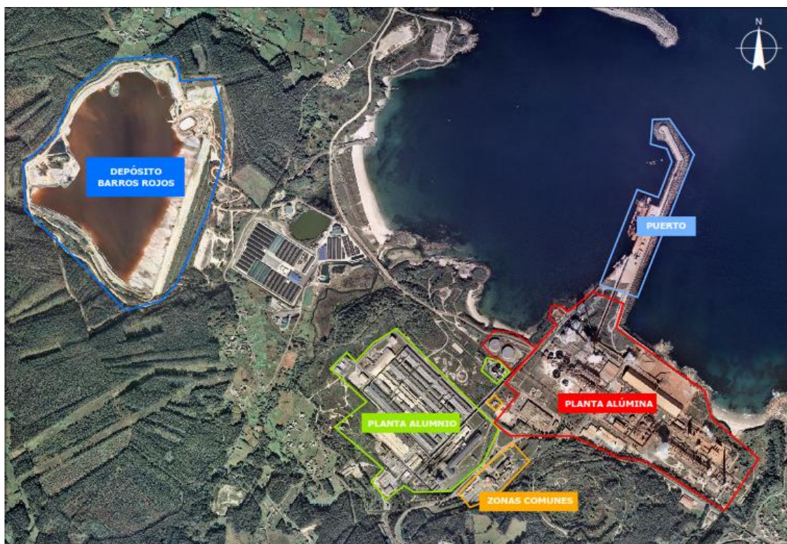
Imagen 01: Vista aérea de las instalaciones del Complejo Industrial San Ciprián
