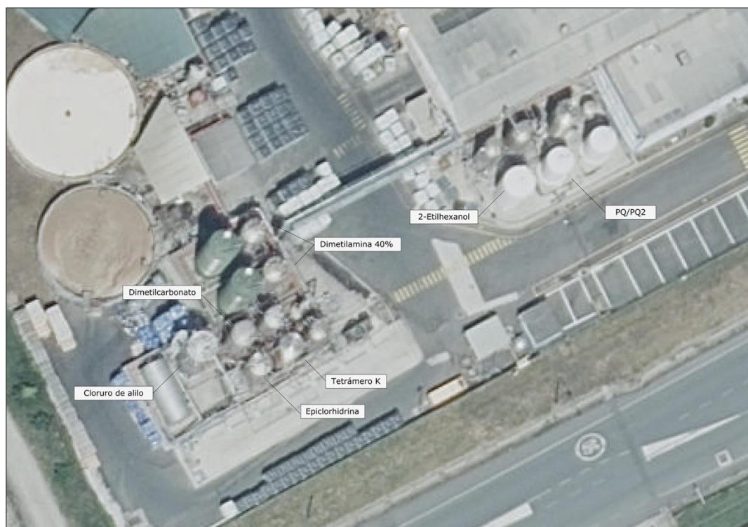
Figura 3. Detalle parques de almacenamiento
