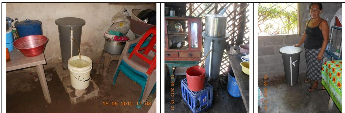
El único detalle para este sistema es que el recipiente receptor de agua filtrada está al descubierto y puede ser frecuentado por moscas, suciedad o polvo. Las familias fueron capacitadas sobre el uso y mantenimiento de los filtros.
