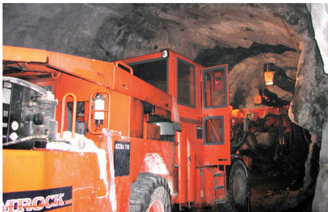
Perforación horizontal con Jumbo.
