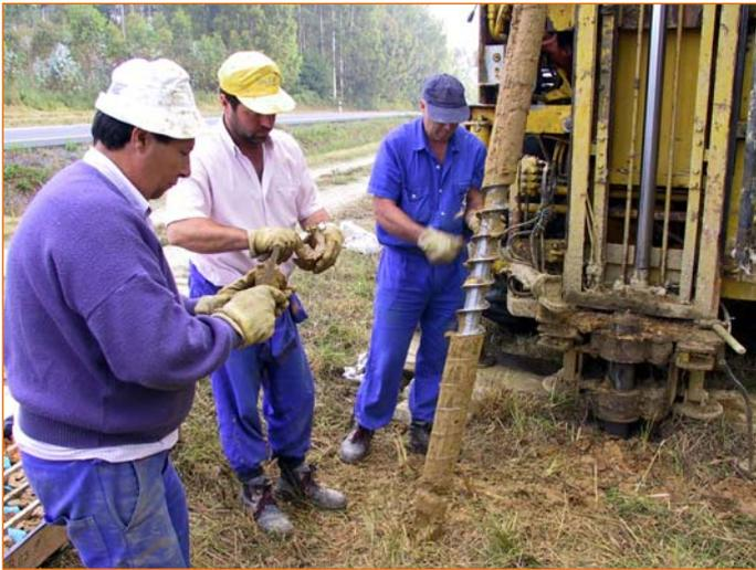
Dicho testigo recuperado se coloca en cajas para su posterior testificación, registro y archivo. Al finalizar el sondeo se retiran las cajas, los caballetes y la máquina para proceder inmediatamente a su restauración, rellenando el hueco con los materiales sobrantes y rechazos, y completando hasta la
