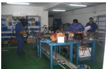
Fabricación e montaxe de instalacións de tubaxe industrial
